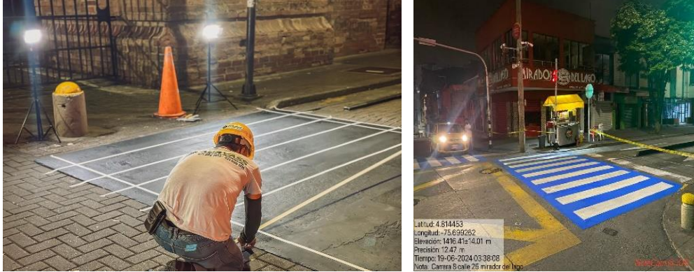
Ilustración 9. Actividades de Señalización Fuente: Subdirección General de Movilidad
